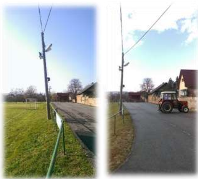
Narovnanie betónového stĺpa v areáli futbalového ihriska, ktorý bol na spadnutie A foci pályán lévő betonoszlop egyenesítése.
